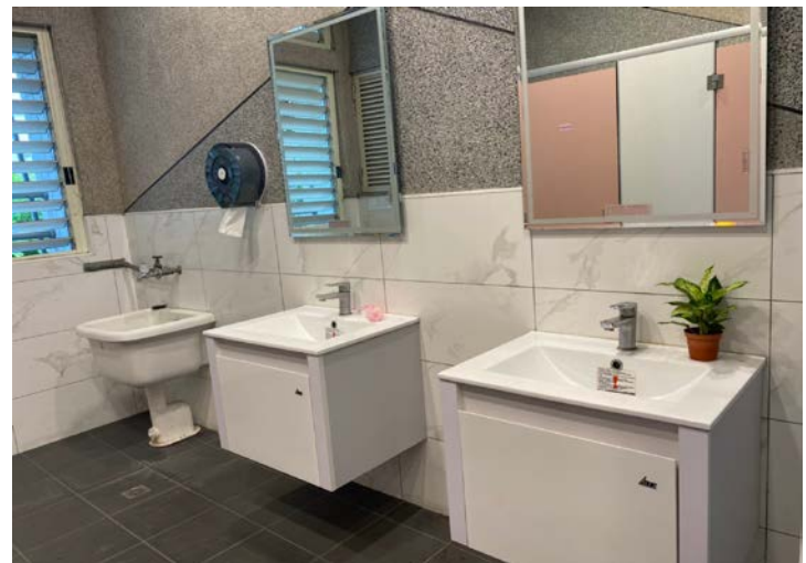
廁所擺設綠化植物
